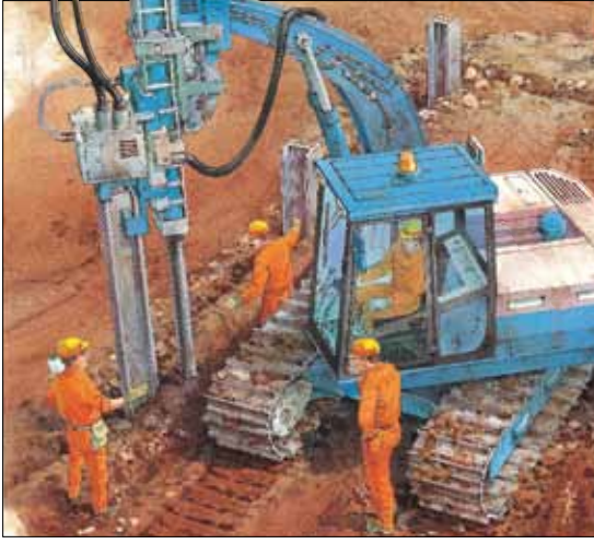
دَقَاقَةُ الخَوَازِيقِ، وهي مطرقة ميكانيكية ضخمة تدق أعمدة معدنية طويلة في داخل الأرض.
